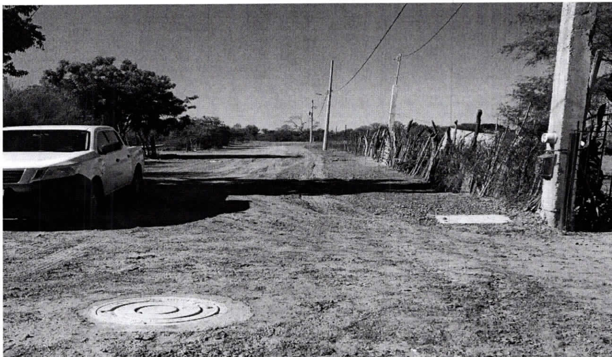
PROYECTO FINALIZADO C-00077/0258 AMP. RED DE ALCANTARILLADO SANITARIO COL. SAN ANGEL BACOBAMPO, ETCHOJOA, SONORA
