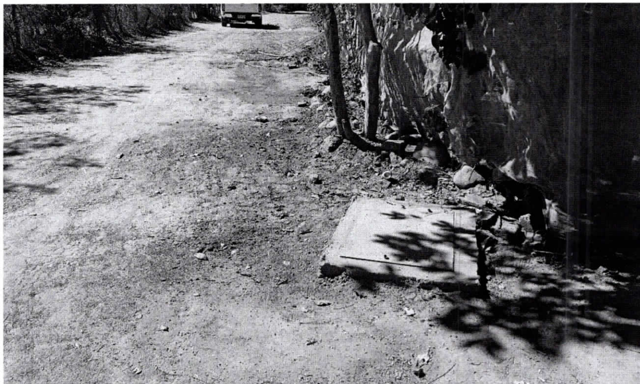
AMP. RED DE ALCANTARILLADO SANITARIO EN SAN PEDRO NUEVO, ETCHOJOA C-00077/0253
