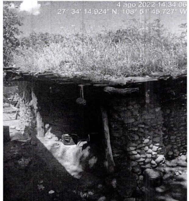
**Vivienda con precariedad en muros y techo de la solicitante María Cerafina Zazueta Yoquibo, viable para proyecto de Cuarto Dormitorio y Baño con Biodigestor.**
