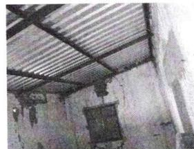
**ID. 38205 CONSTRUCCION DE TECHO FIRME DE LAMINA TRES.-** LOS BENEFICIARIOS QUISIERON QUE SE LES PUSIERA EL TECHO ARRIBA DEL QUE TENIAN. SE OBSERVA EN LA FOTO POR FUERA EL TECHO ENCIMA, CON EL APOYO RECIBIDO (TERCER FOTO)
